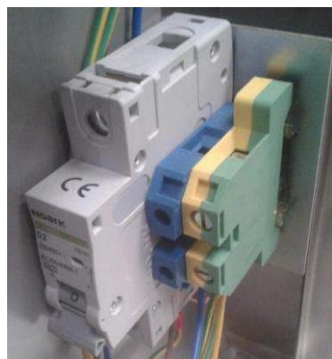
*Рисунок 12– Подключение кабеля питания*
