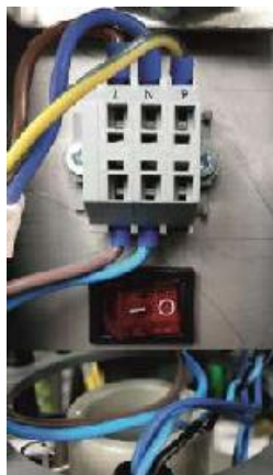
а) Подключение кабеля питания
