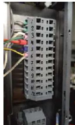
б) Подключение кабеля связи с пультом управления к клеммам
