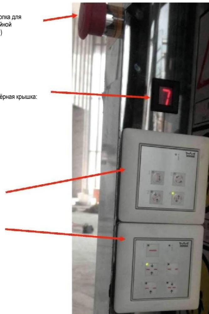
Нажимная кнопка обеспечения доступа для инвалидов (9501460007600)
