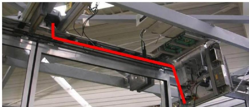
Розетка питания для устройств с низким тепловыделением (расположенная на блоке управления) должна быть подключена к данному кабелю коллектора.
